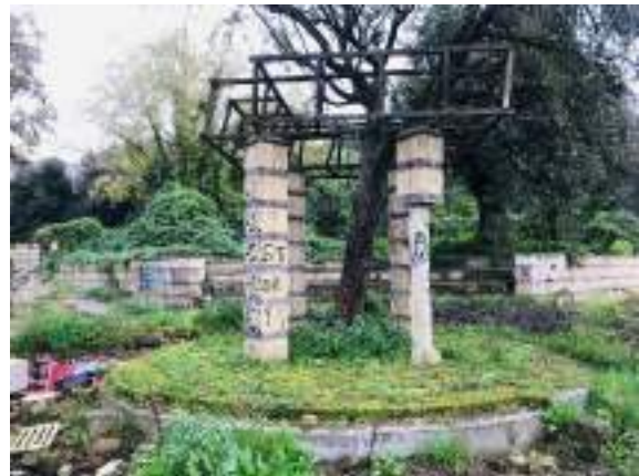
Deterioramento delle strutture lignee a copertura degli elementi architettonici
