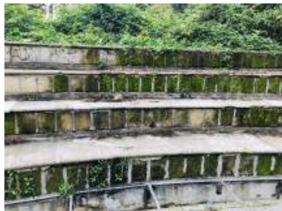
Fenomeni di degrado sulle gradonate circolari centrali
